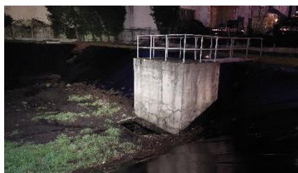
Bassin bâché sans eau – Bassin de Voltaire
