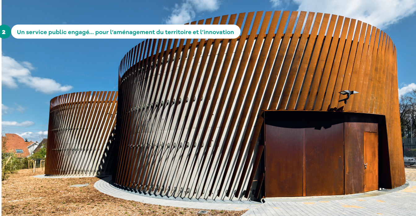
Station de pompage de Bruyères-de-Sèvres
