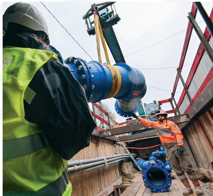
Chantier de performance réseau à Argenteuil
