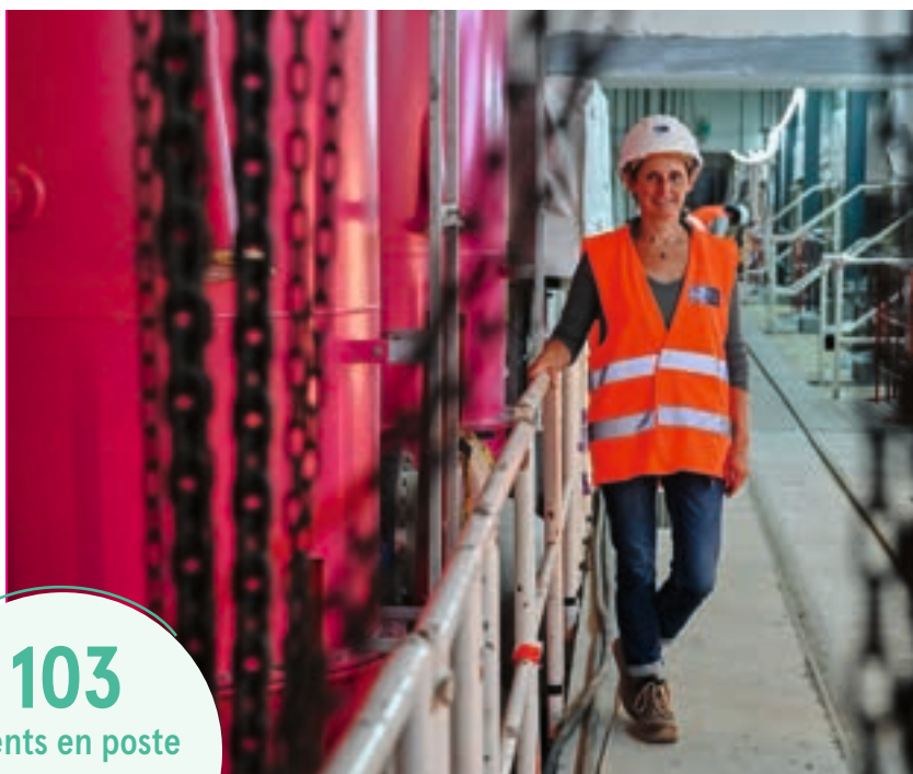
Emmanuelle RODELET sur le chantier unités de filtration à l'usine de Méry-sur-Oise.
