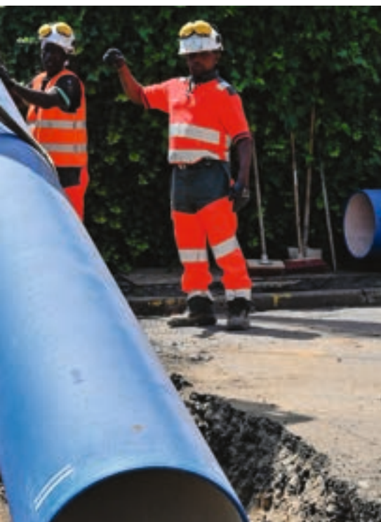
Chantier de renouvellement de Livry-Gargan (93)
