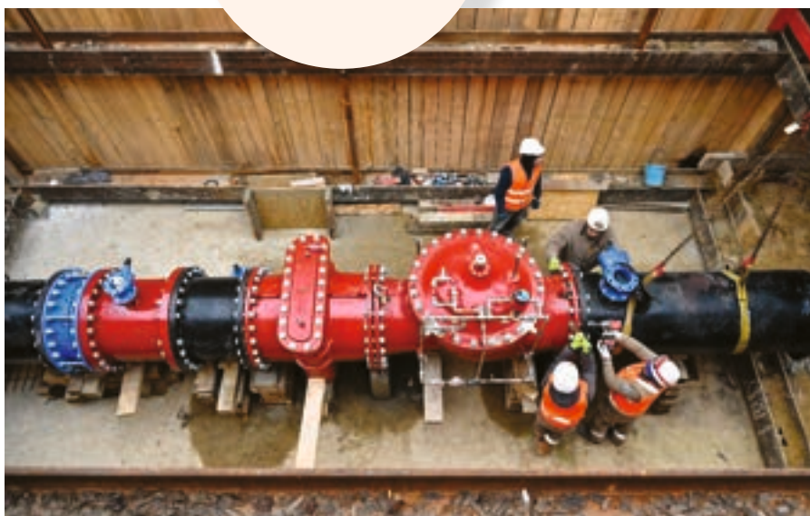
Mise en place de la vanne de modulation DN 800 mm - Clichy-la-Garenne
