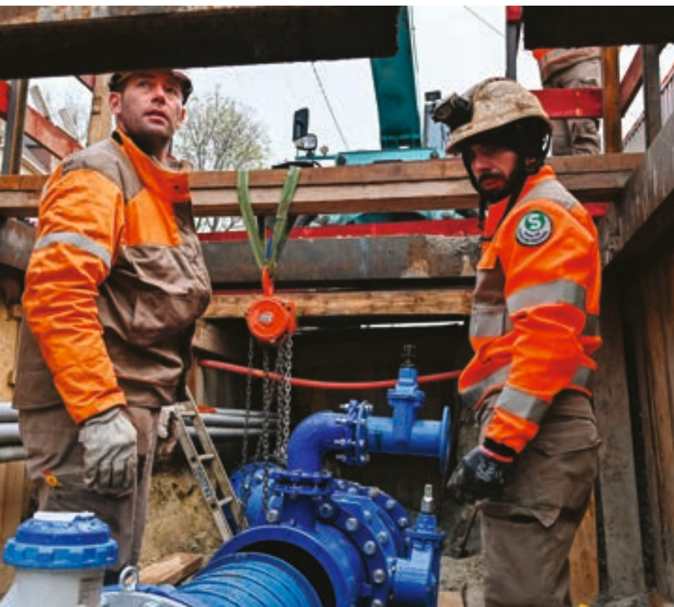
Montage d'une nouvelle ligne hydraulique à Argenteuil
