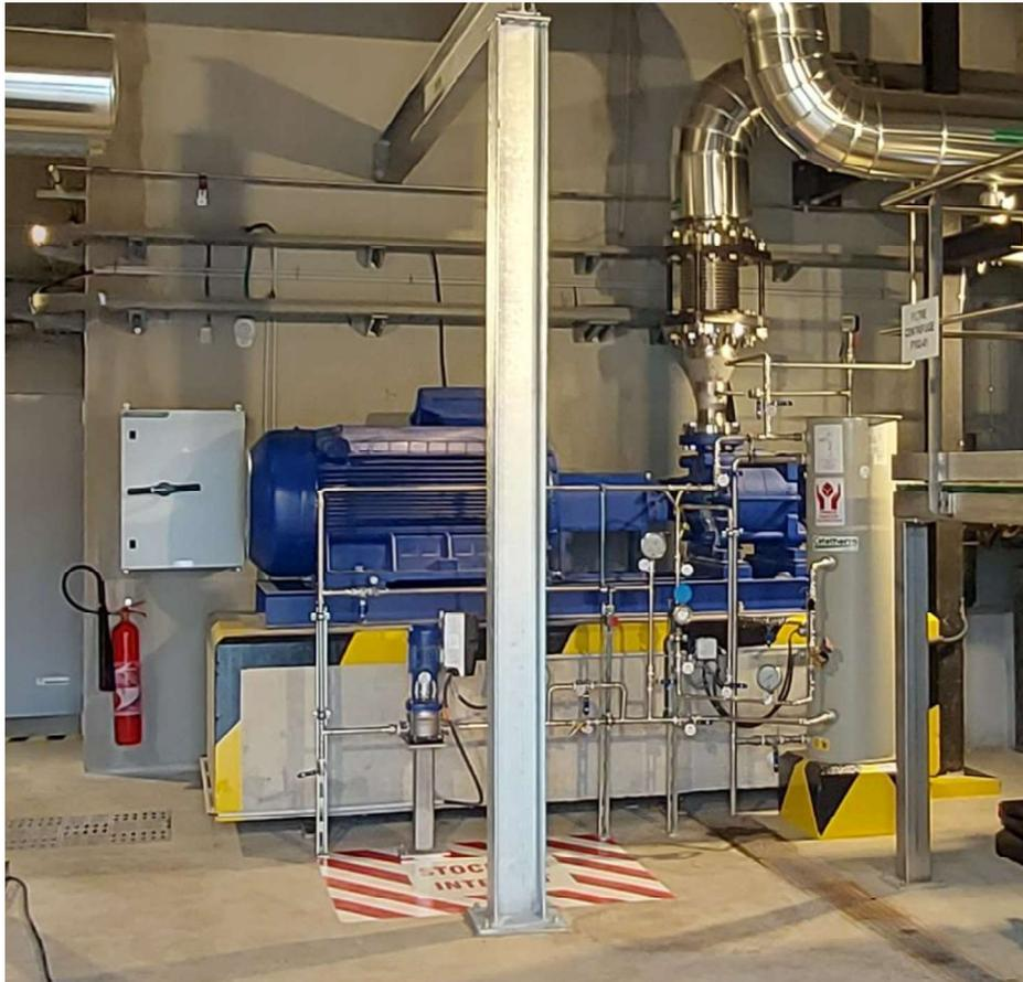
Vue d'une pompe de réinjection sur massif inertiel (Site DALKIA)
